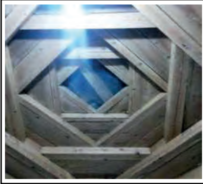
Foto 5 Bayburt Eymür köyü-aşhane tütüklü tavan
